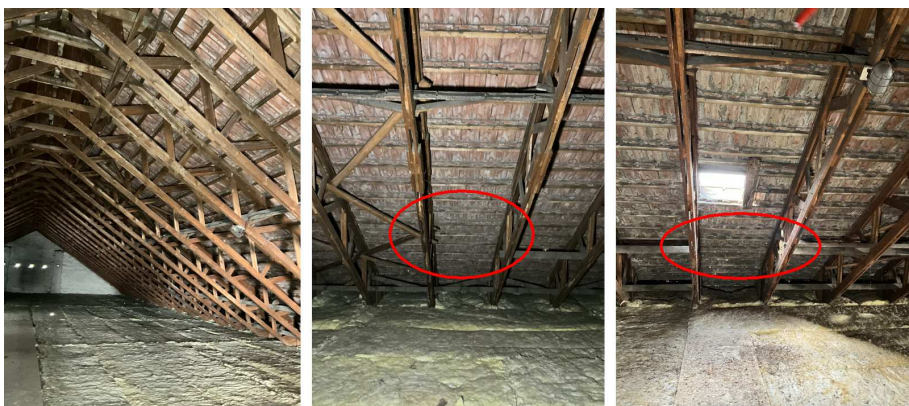
konstrukce krovu, červeně chybějící zavětrování
